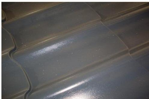
*La tôle tuile est une plaque emboutie au motif des tuiles, destinée aux couvertures.*
